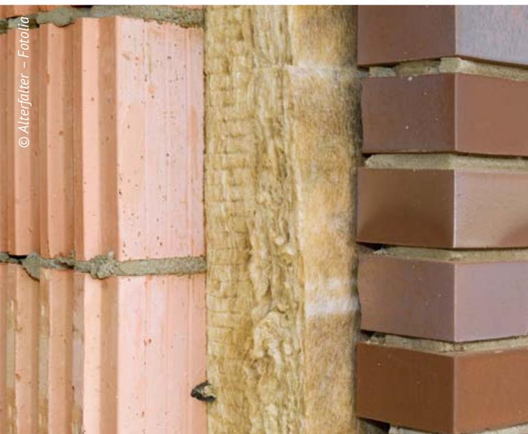
Hinterlüftung (Luftschicht), die Wärmedämmung und die an der Hauswand verankerte Unterkonstruktion (Latten- oder Metallkonstruktion). Die Dämmschicht wird so in die Unterkonstruktion eingebracht, dass
